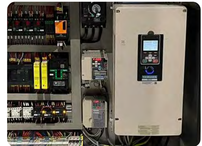
Sanfter Anlauf und Stopp von Messern und Schüssel durch elektronische Frequenzumrichter.
